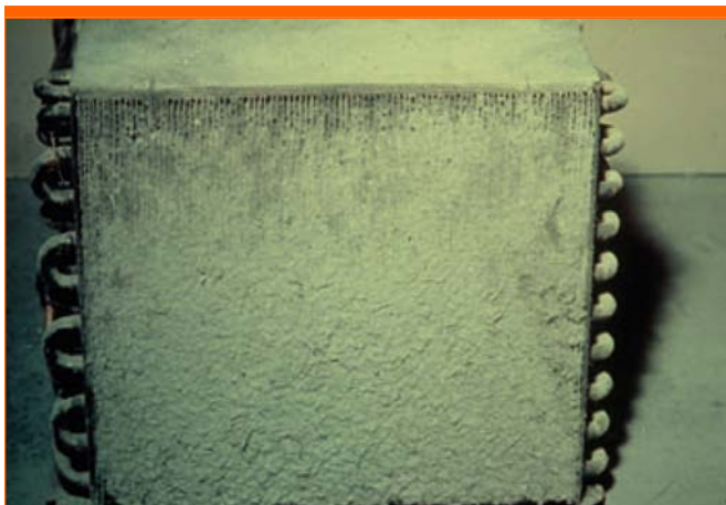
Figura 3 – Condensador Sucio
