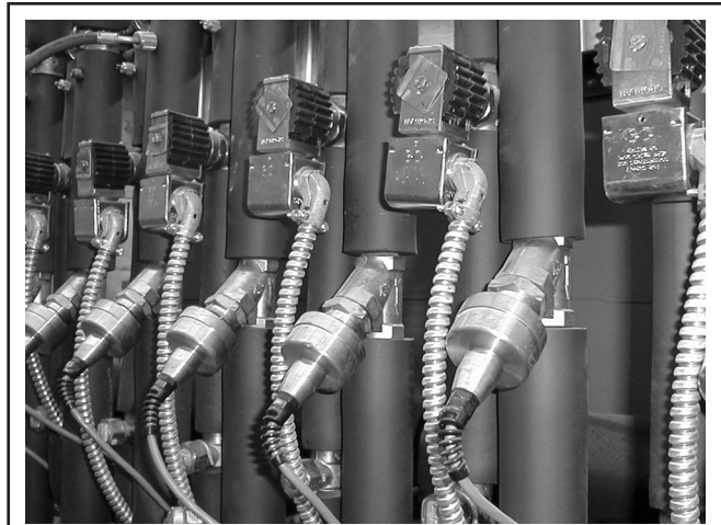
Aunque los controladores de temperatura en mostradores fueron los primeros en el mercado, controladores RACK están aumentando en popularidad debido a su menor costo y habilidad de controlar múltiples válvulas.
